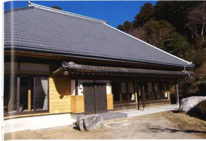
再生後南側外観 屋根はもとの茅を下地にガルバリウム鋼板葺き。
