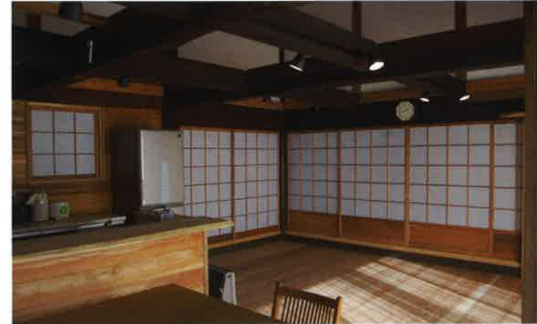
LDK 内壁と床のほかにキッチンカウンターと障子も裏山のスギを利用して作った。
