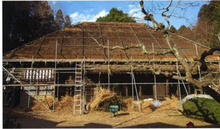
屋根施工中 茅の状態は良好だったので整形して下地として残した。
