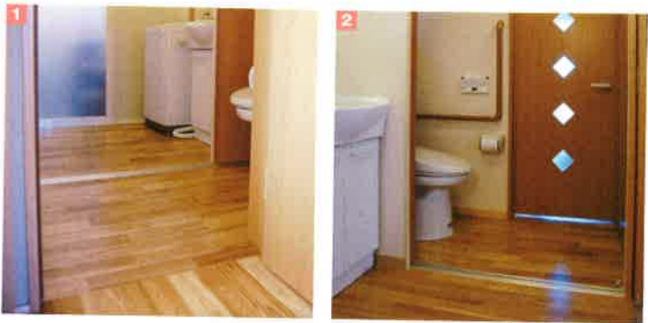
2枚引き戸を開放すると洗面所とトイレが一体となり、車いすでも使える空間が生まれた
